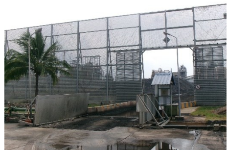
ภาพที่ 2.2-12 พื้นที่ล้างล้อรถบรรทุกก่อนออกจากพื้นที่ ลานกองเก็บถ่านหินกลางแจ้ง
