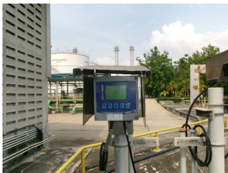
ภาพที่ 2.2-19 pH Meter แบบอัตโนมัติ บริเวณบ่อปรับสภาพกรด-ด่าง
