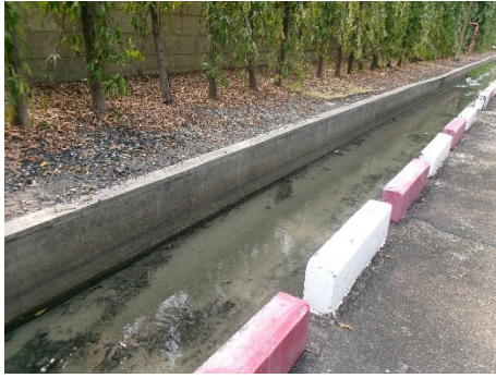
ภาพที่ 2.2-20 ร่องน้ำขนาดกว้าง 2 เมตร ลึก 1.5-2.2 เมตร ล้อมรอบกองถ่านหิน
