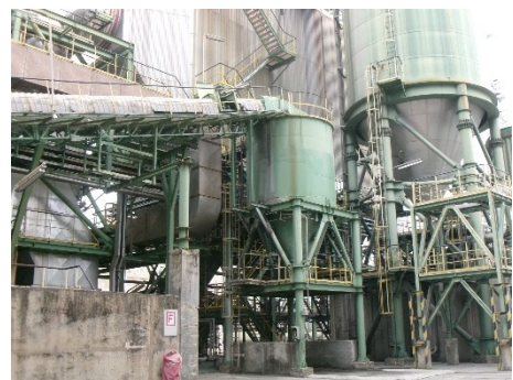
ภาพที่ 2.2-31 ไซโลหรือ Collecting Pit เก็บถ่านหินแบบปิด
