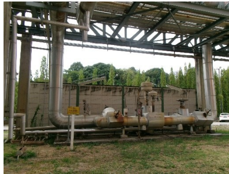
ภาพที่ 2.2-42 ระบบฉนวนป้องกันความร้อน และการปิดคลุมที่แหล่งกำเนิดความร้อน
